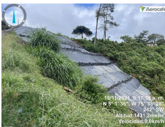
Instalación de trinchos en guadua, perfilamiento de taludes, protección de taludes y rocería.
