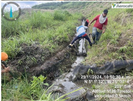
Conformación de canales en tierra y geotextil
