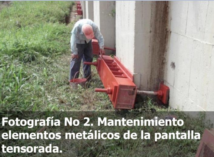
**Fotografía No 2. Mantenimiento elementos metálicos de la pantalla tensorada.**
