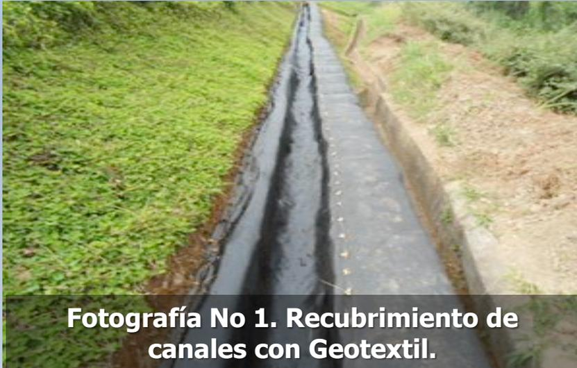
Fotografía No 1. Recubrimiento de canales con Geotextil.
